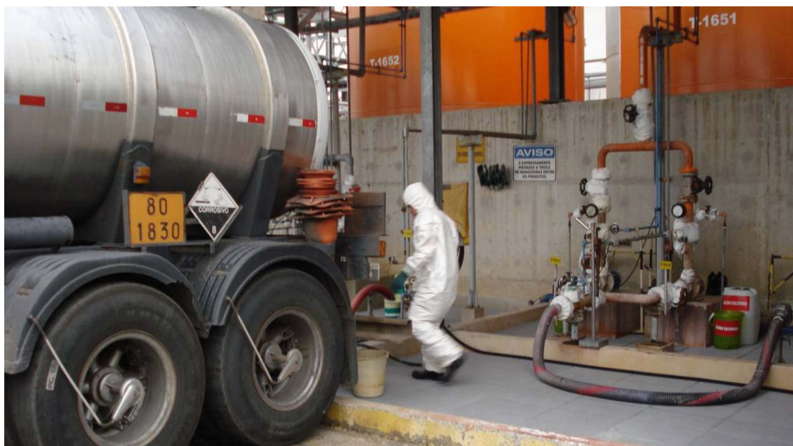
Figura 5 – Momento de carregamento dos Tanques de HCl.
